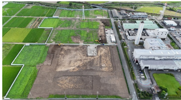
造成工事開始後（令和 6 年 7 月）
