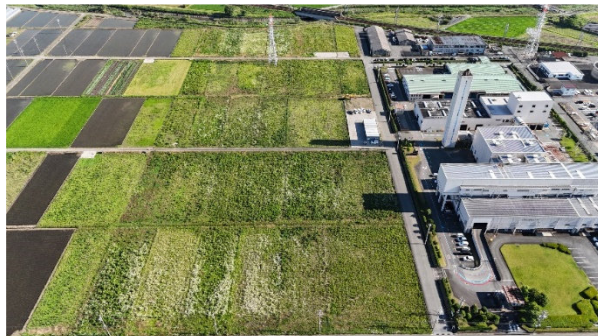
造成工事開始前（令和 6 年 6 月）
